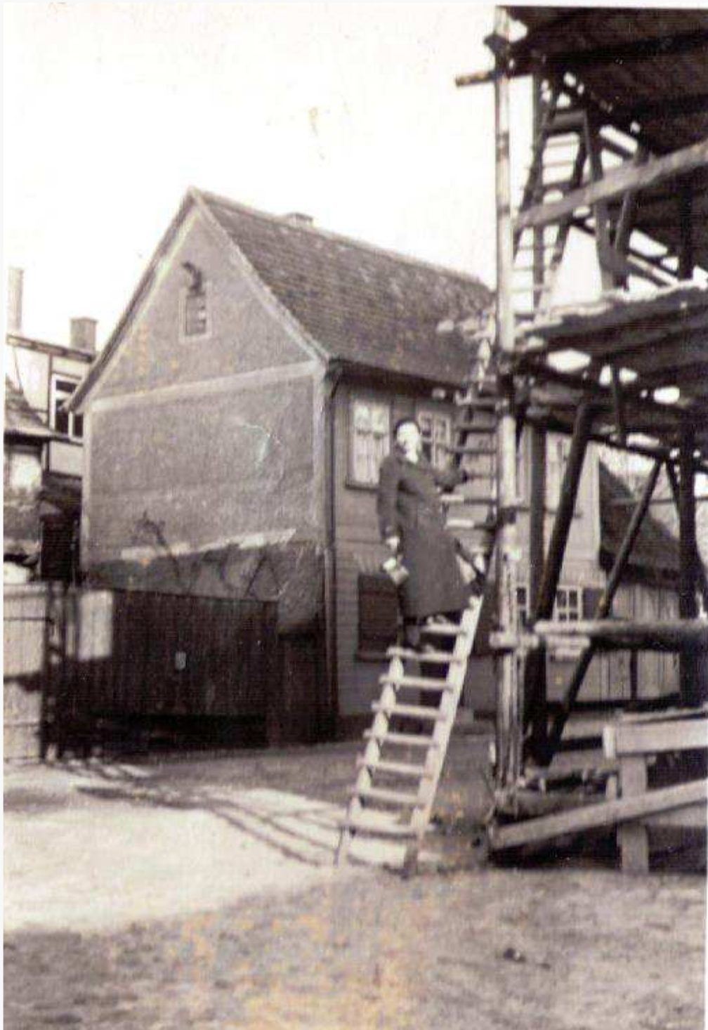
Verfugen und Abputz Kirchturm 1939
