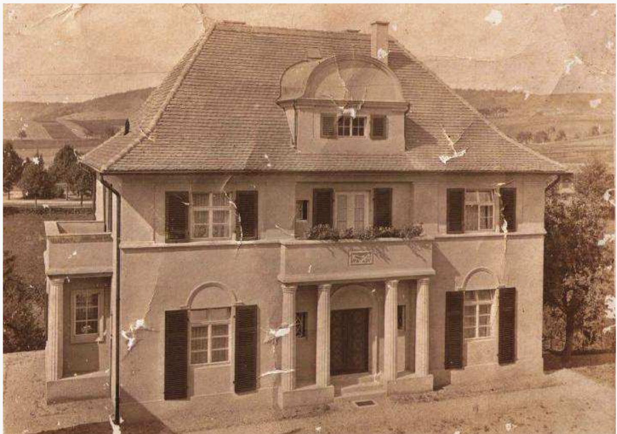
Neubau des Wohnhauses der Familie Kroneberg in der Bahnhofstrasse
