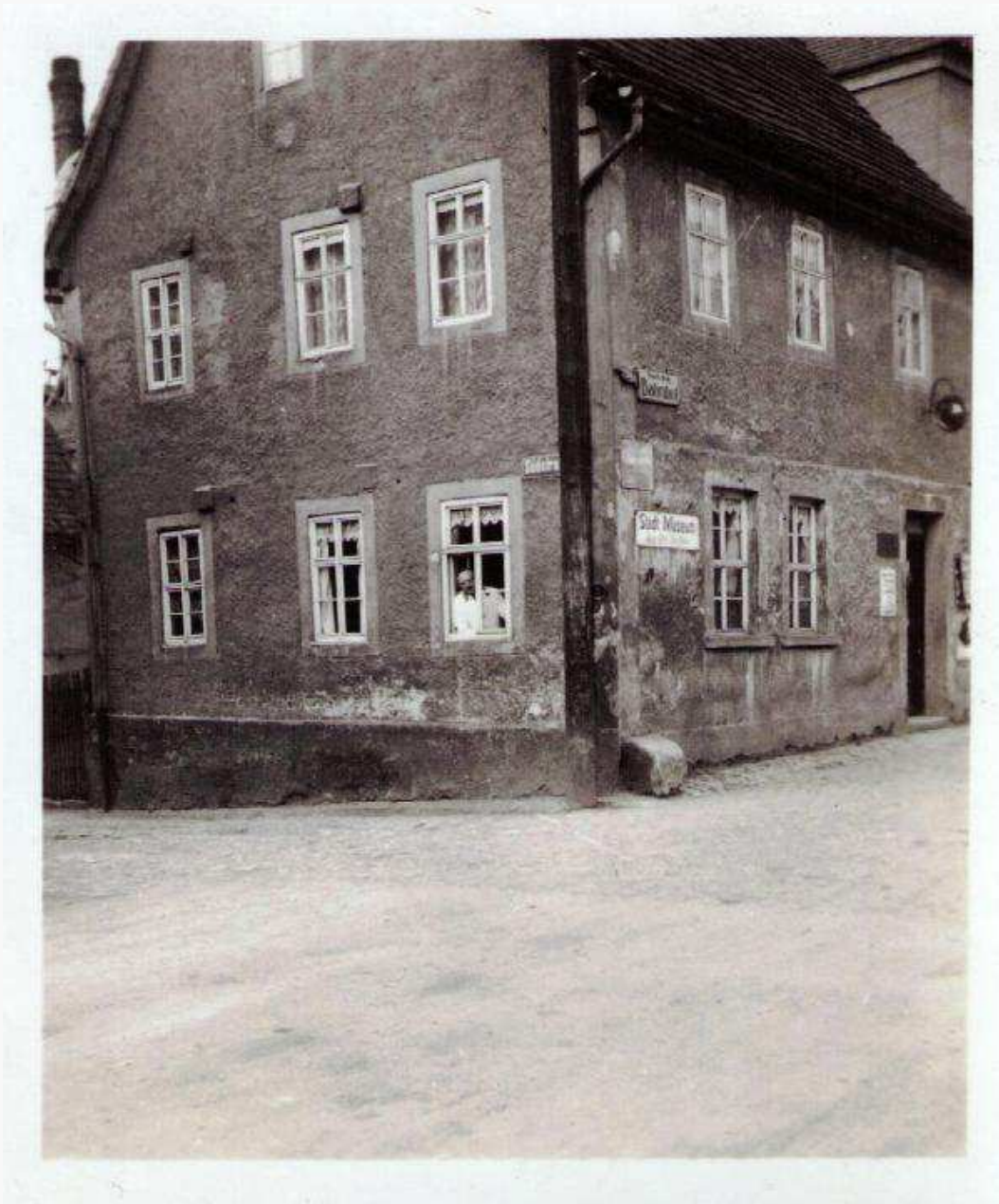
Haus Ecke Südstrasse
